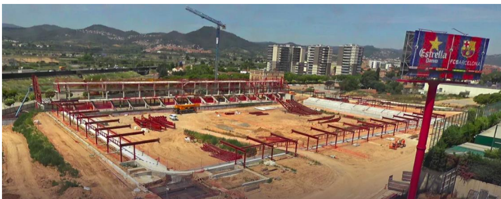
Figura 24: Construcción del estadio (2017)
