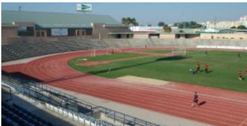
AMPLIACIÓN. La reforma del Estadio Bahía Sur incluye la transformación de todo el graderío. / LA VOZ
