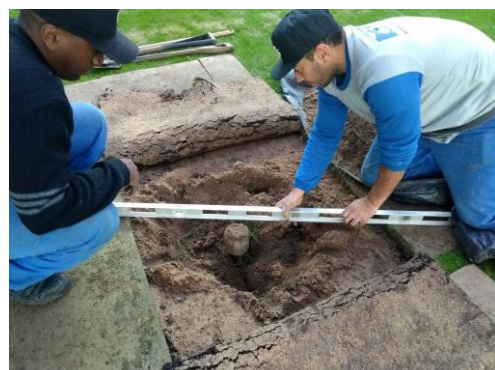
Figuras 3 e 4: Instalação de aspersores escamoteáveis.
