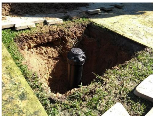
Figuras 3 e 4: Instalação de aspersores escamoteáveis.
