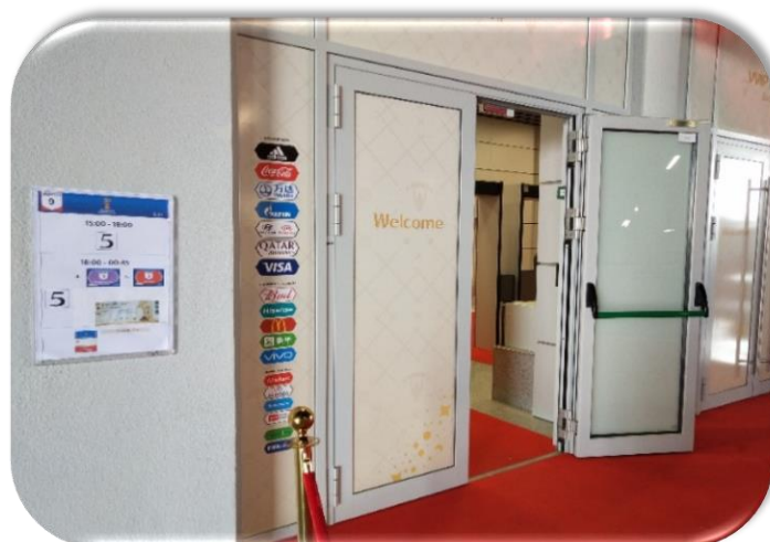
Figura 29: Puerta antipánico que abre hacia el exterior del recinto
